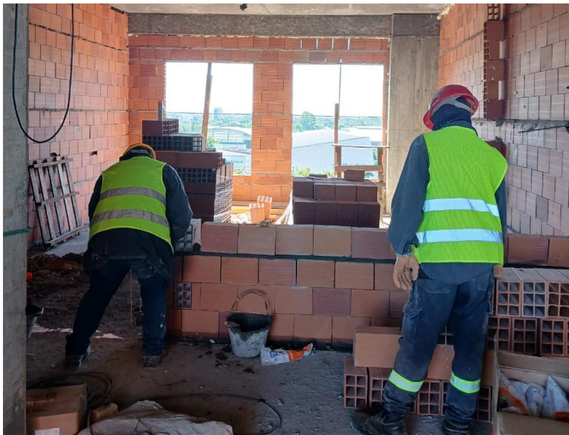
Trabajos de mampostería y revoque en Torre 20
