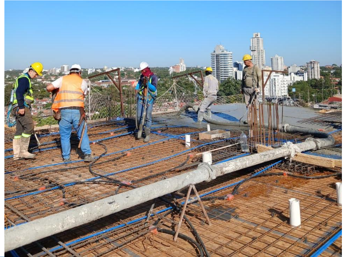
Cargamento de Losa en Torre 20
