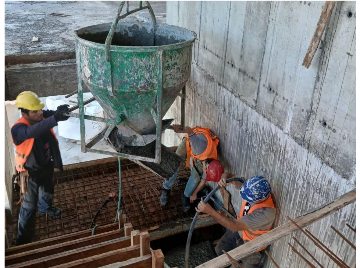
Trabajos de preparación de armaduras y cargamento de escalera en Torre 21
